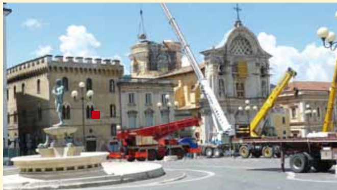
■ La piazza dell'Aquila con le gru
